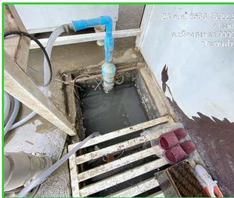
ภาพที่ 2-3 บ่อดักตะกอนบริเวณทางเข้าพื้นที่โครงการก่อสร้าง
